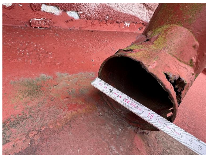
foto/26/ Degradace střešního svodu
