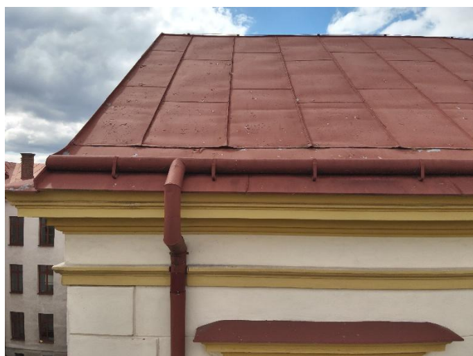
foto/06/ Pohled na systém odvodnění střechy
