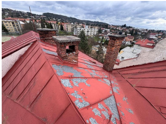
foto/12/ Degradace ochranného nátěru
