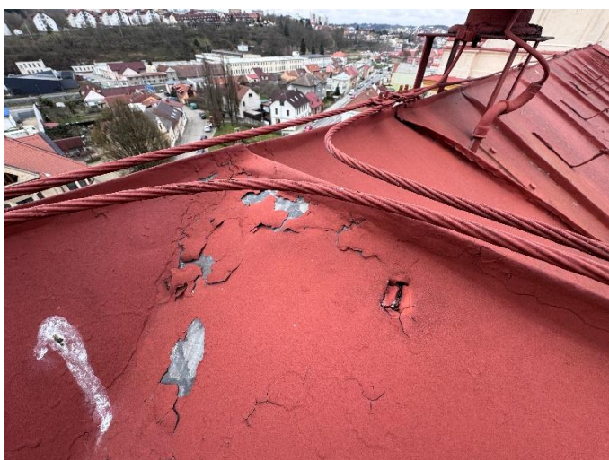
foto/15/ Degradace ochranného nátěru
