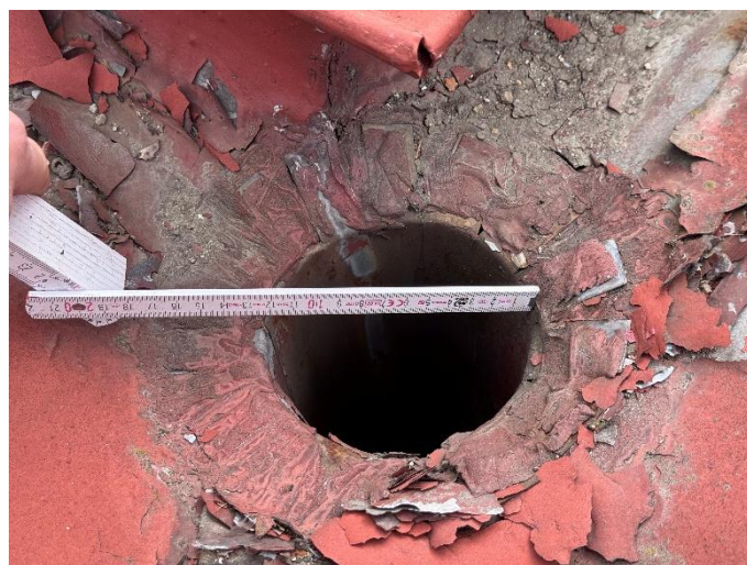
foto/24/ Napojení žlabu na svod
