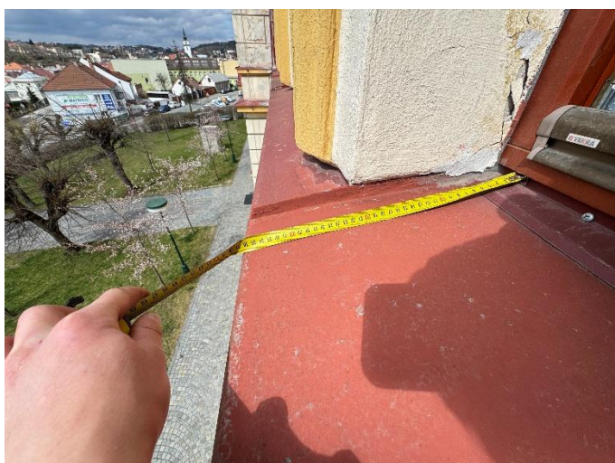
foto/35/ Šířka okenního parapetu 2.NP
