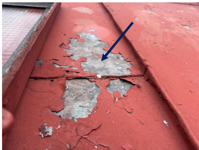
foto/14/ Degradace ochranného nátěru
