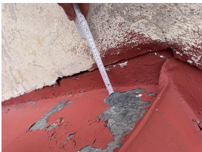
foto/17/ Oplechování v místě svislé konstrukce
