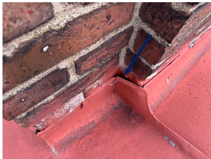
foto/30/ Oplechování komínového tělesa
