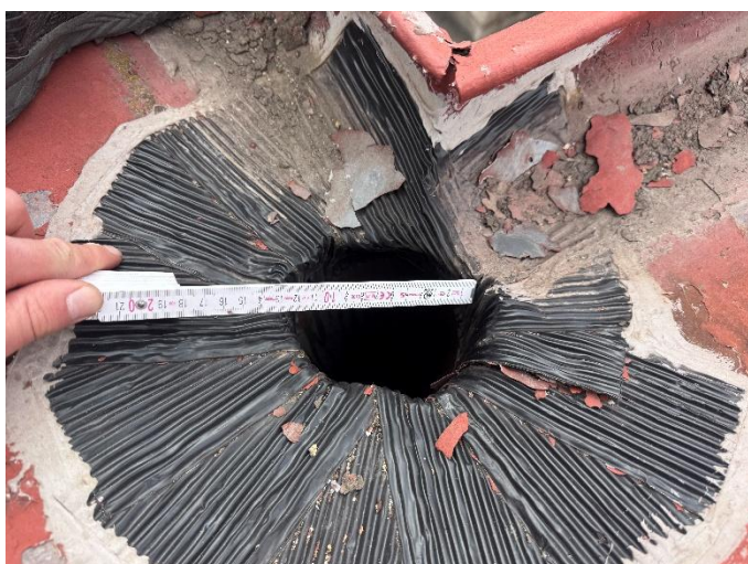
foto/25/ Oprava napojení žlabu na svod
