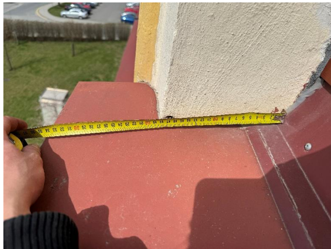
foto/36/ Šířka okenního parapetu 3.NP
