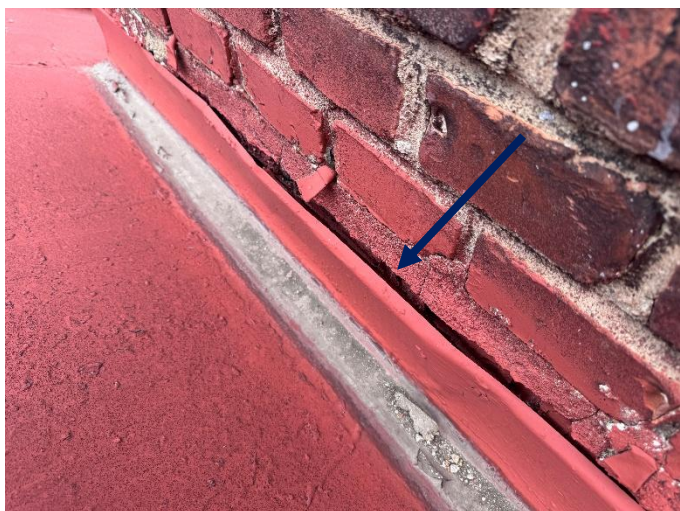
foto/31/ Oplechování komínového tělesa
