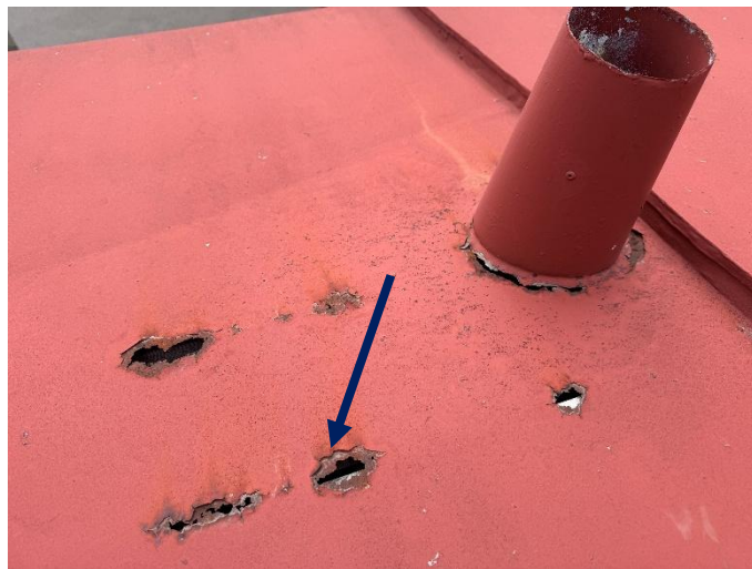
foto/16/ Porucha/netěsnost v ploše krytiny
